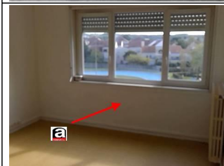
Photo n° PhA003 Localisation : Entrée; Dégageant; Chambre 1; Placard; Séjour; Chambre 2 Ouvrage : 3 - Parois verticales intérieures - Murs et cloisons maçonnés Partie d'ouvrage : Enduit à base de plâtre lissé ou taloché Description : Enduit à base de plâtre lissé ou taloché
